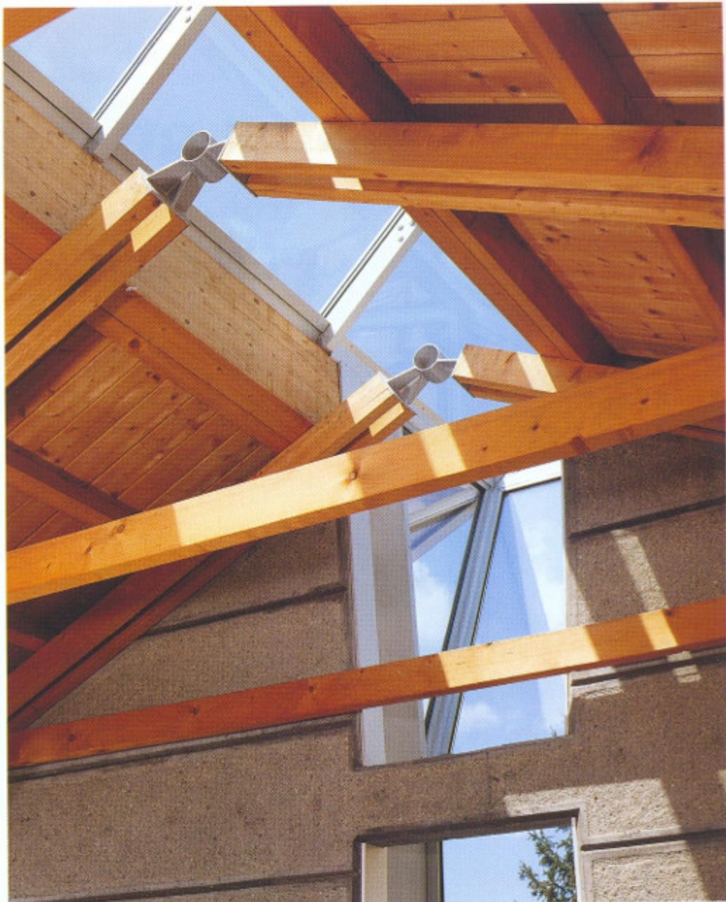
Sul soffitto ancora si riprendono i temi della tradizione: ecco il legno lamellare per le capriate e altre tavole lignee per i rivestimenti, mentre l'esterno è in coppi. Ma la novità sta nel lungo lucernario: è totalmente apribile così che durante l'estate l'aria calda che vi si accumula sotto possa disperdersi favorendo la circolazione interna. Così si mantiene il controllo climatico ambientale. Gli aggetti esterni completano alle estremità il lucernario.
